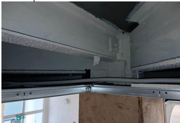
Fot.1 Połączenie I220/I300
